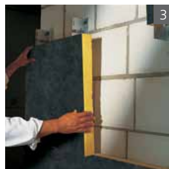
AT-Mineralwolle- Dämmplatte verlegen
