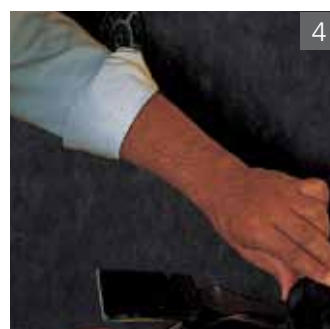
Dämmstoffplatten mit Dämmstoffhalter V befestigen
