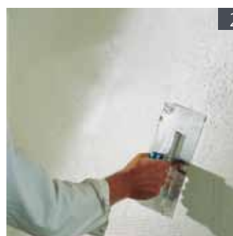
Armierung aufbringen und Glasfasergewebe einlegen
