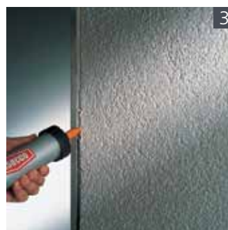
Außeneckfuge mit PU-Fugenmasse abdichten
