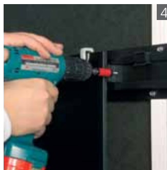
4 Verschiebesicherung montieren
