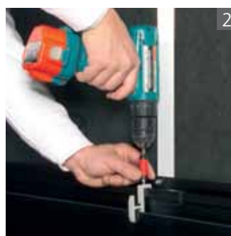
2 Startklammer, Mittelklammer und Endklammer montieren
