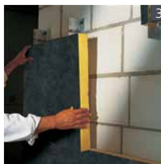
AT-Mineralwolle- Dämmplatte verlegen
