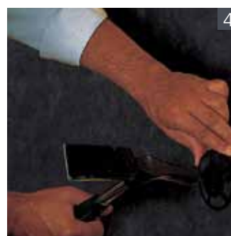
Dämmstoffplatten mit Dämmstoffhalter V befestigen
