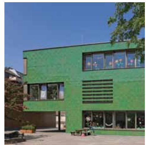
Die elegante Glasfliesenfassade hebt die skulpturale Form des Baukörpers der Offene Ganztageschule (OGTS) in Köln hervor (Architekten JSWD, Köln).
