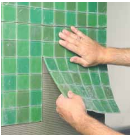
Auf Folie vorgefertigte Mosaikstücke werden auf der Baustelle mit Klebemörtel auf die Trägerplatte befestigt.
